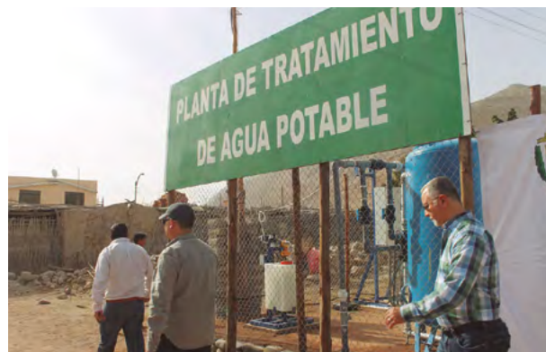
En inspección a Planta de Tratamiento de Agua Potable en anexo El Pedregal.
